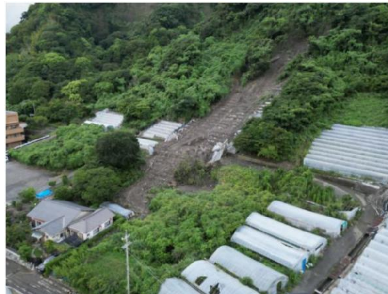
静岡県静岡市の土砂災害 (9/1 撮影 静岡市提供)
