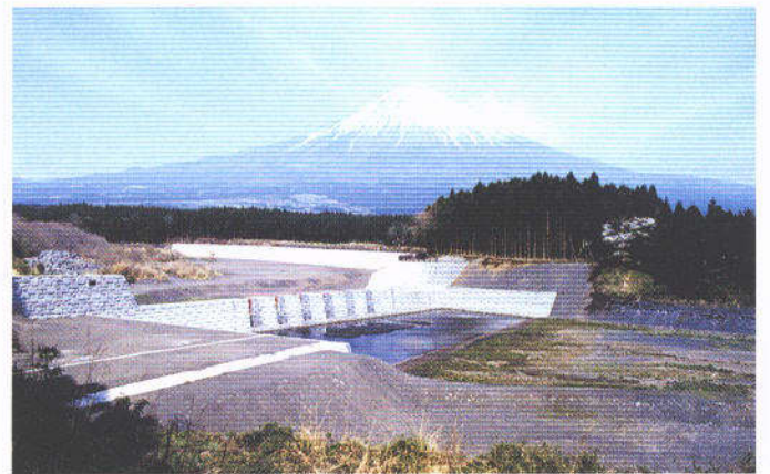
猪の窪沈砂地工 (静岡県富士宮市)
