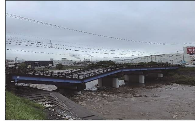
令和3年7月 沼津市黄瀬川大橋
