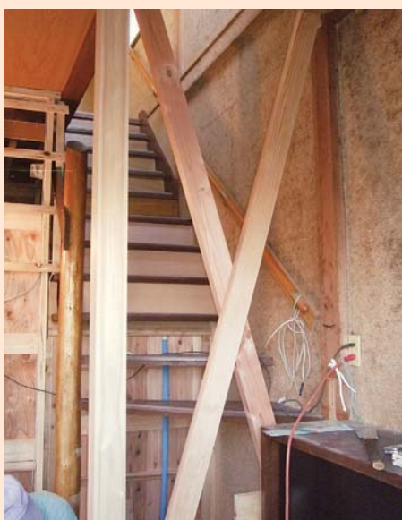
1階玄関ホールに新設した筋かい
