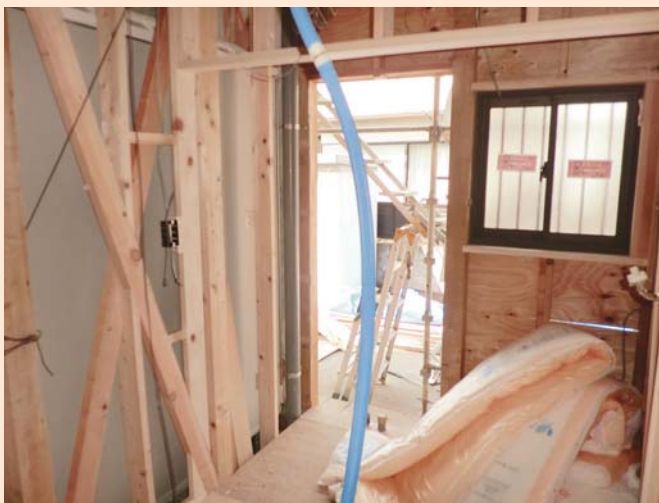
便所、浴室間に新設した筋かい
