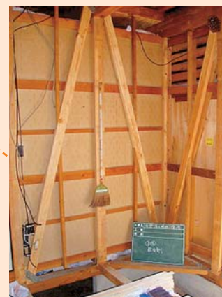
1階に新設した筋かい
