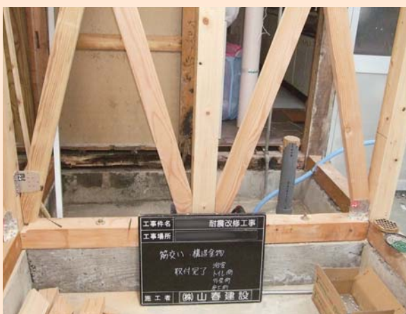
便所、浴室間に新設した筋かい
