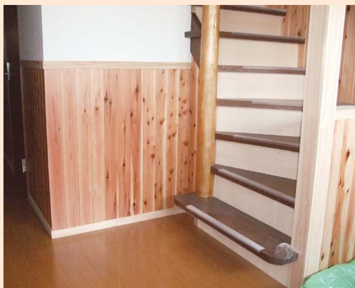
廊下、階段の腰壁に県産材を使用 筋かい設置に伴う内壁復旧工事にあたり、内壁の仕上げ材として県産材を使用しました。
