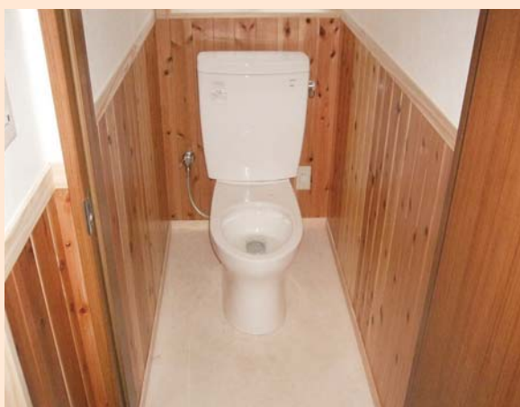
便所の腰壁に県産材を使用
