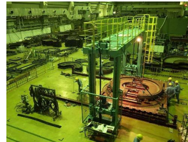
2号機 タービン解体状況
