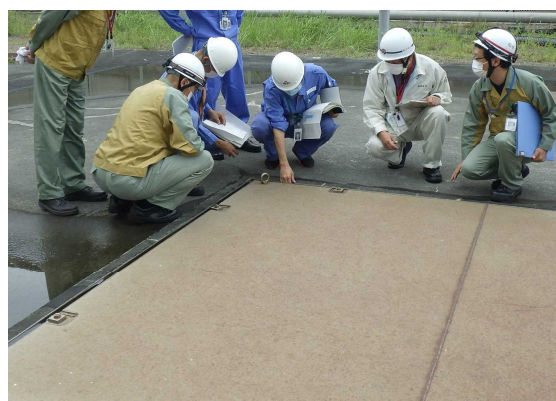
水密蓋の状況を確認
