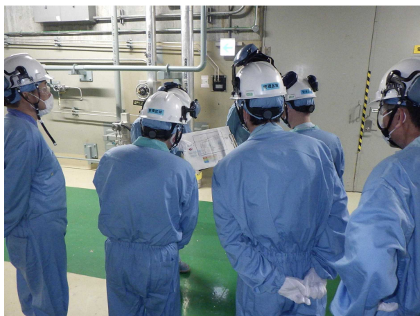
追設した配管及び弁について説明を受ける様子
