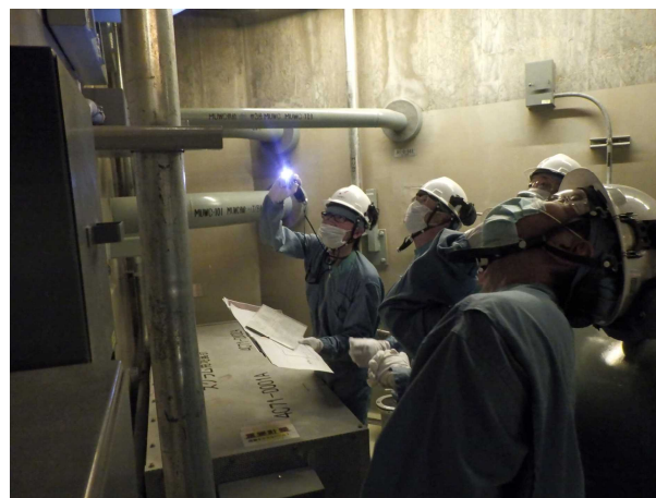
追設された配管の設置状況を確認
