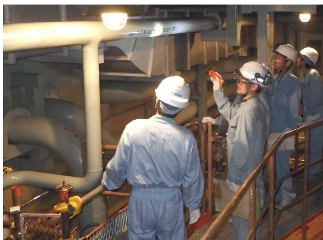
配管据付け状況の点検の様子
