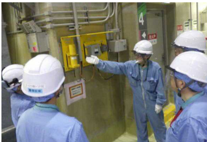
<写真2：燃料プール付近に設置した放射線モニタを確認している様子>
