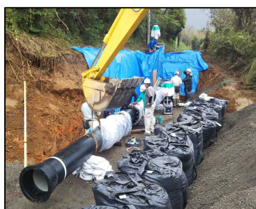
↑ 台風19号の復旧状況
