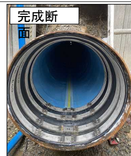
完成断面 既設管の内側を更生材で、 自立耐震管に形成
