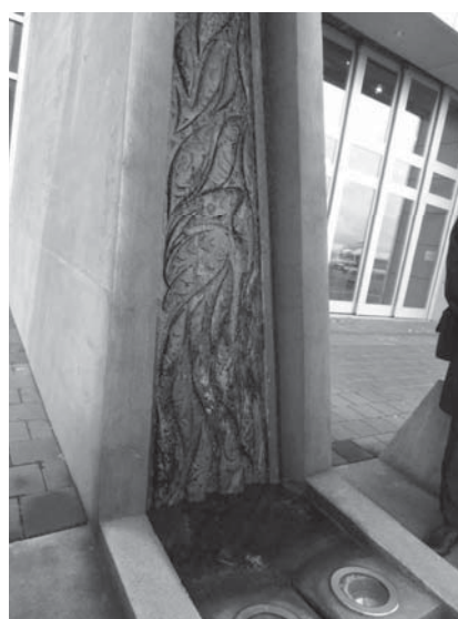
青サギのレリーフが施された雨樋
