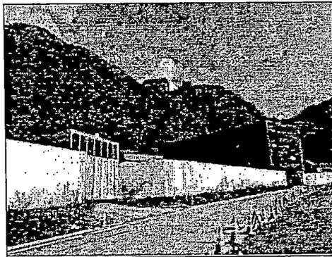
坑口は建屋で覆われているが、先進坑1600mのうち3割の掘削が完了している。発生土に基準値を超える「ホウ素」が確認。トンネル内に仮置き中。
