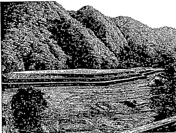
村に行く途中、小渋川の河原に残土置き場があった。盛土は静岡工区に残土置き場も大井川岸にこのような形で置かれると思われる。しかし、ここの盛土の高さは15、6m程であるが、大井川燕沢の残土置き場はなんと65mの計画である。見えている山の頂上位の高さになる。
