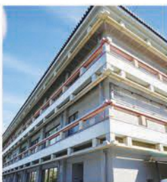
磐田市役所西庁舎
