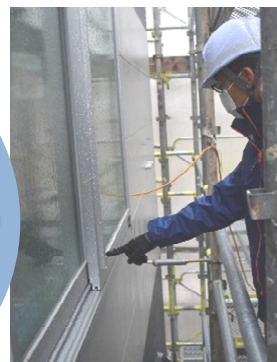
施工状況の確認、検査
