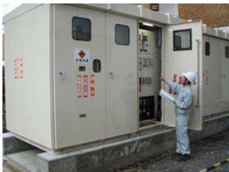
《電気設備の工事監理》
