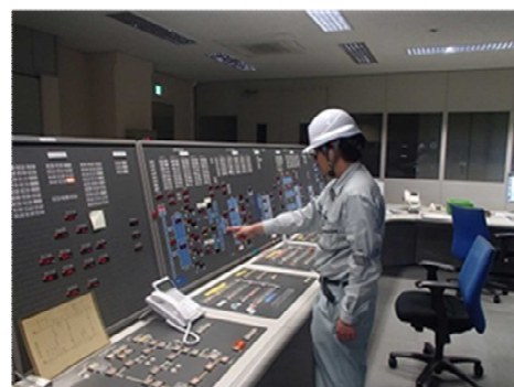
《下水道施設の維持管理》
