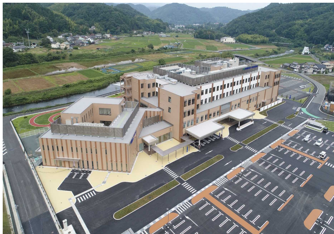
完成写真 東方向より
