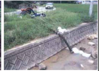
仮設ポンプを設置し、用水を確保
