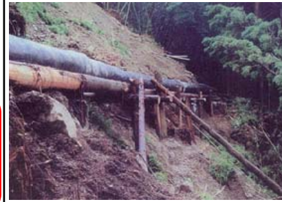
仮設水路を設置し、用水を確保
