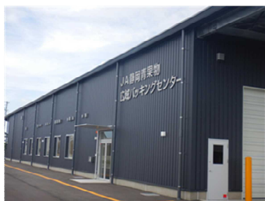
▲広域パッキングセンター
