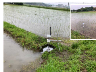
▲自動給水栓、水田センサー （掛川市）
