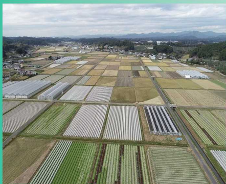
水田の基盤整備
