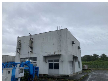
▲遠隔監視制御 浜部排水機場（磐田市）
