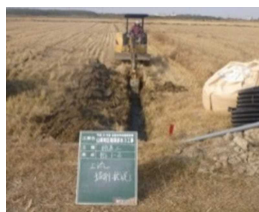
▲暗渠排水 森町とうもろこし の里2期地区（森町）
