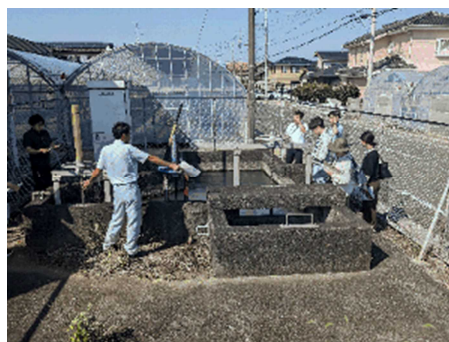
県営伊佐見用水4号分水工
