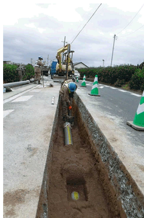
工事の様子（管の更新）
