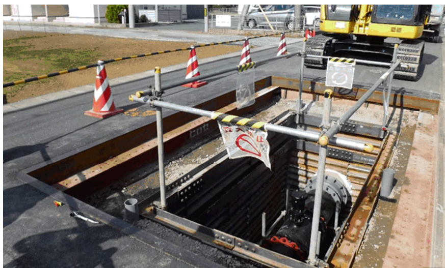
狸ヶ谷用水路で管更生工法に必要な立坑を施工中
