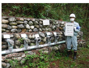
農地防災施設の点検
