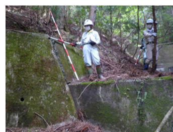
治山施設の点検
