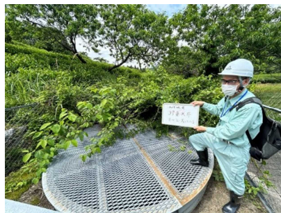
農地防災施設の点検
