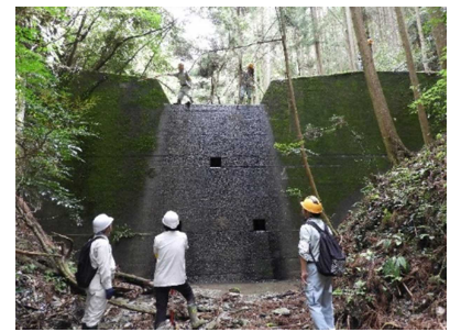
治山施設の点検
