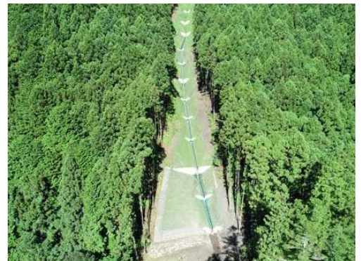
復旧工事完成後の山腹
