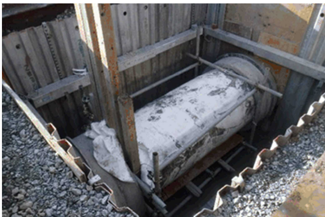
挿入された新しい用水管
