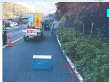
除草作業中・・・
