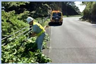
職員による道路パトロール(除草作業)の様子
