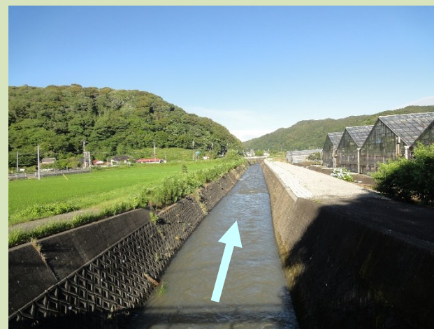
施工予定箇所
