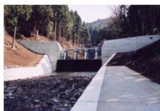
△型スリット(流木止め) えん堤 滝沢川(小山町小山)
