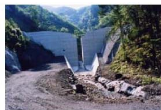
透過型コンクリートえん堤 宇城川(静岡市葵区口坂本)
