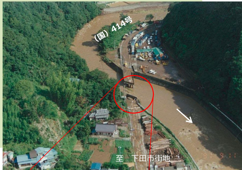
【下田市】 稲生沢川（志戸橋落橋）
