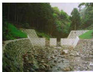
透過型コンクリートえん堤 氷川(静岡市葵区黒俣)
