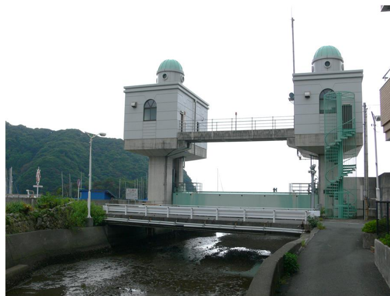
管内の水門の事例: 安良里浜川水門 (西伊豆町安良里)
