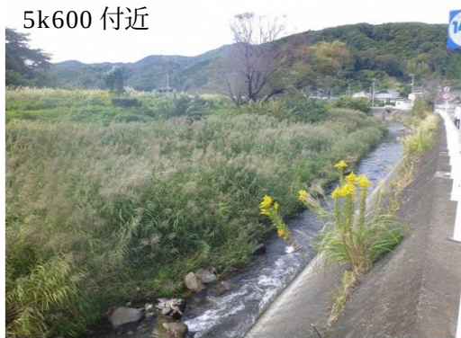
図 1-2 0 しろかに橋上流 土砂堆積と草木繁茂
