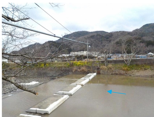
図 4-4 伏倉橋水位観測所（水位計）
