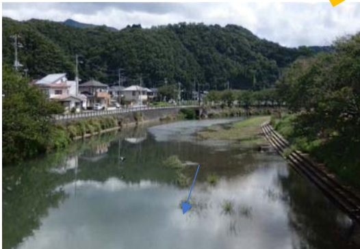
1.6k付近河道状況 伏倉橋付近。低水管理の代表地点。
