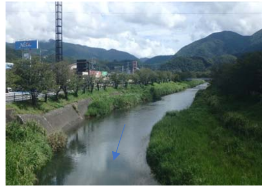
1.0k付近河道状況 後背地は松崎町の中心的な市街地が広がる
