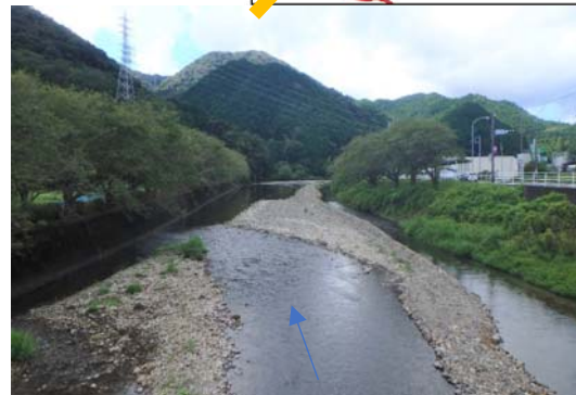
3.7k付近河道状況 後背地は水田としての利用が多い。
