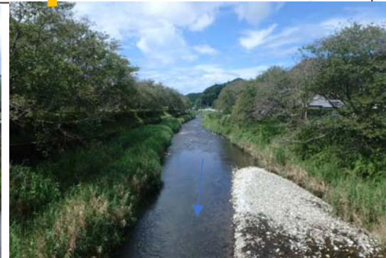
4.8k付近河道状況 後背地は水田としての利用が多い。
