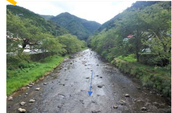
6.6k付近の河道状況 後背地は急勾配となり、山間部を流れる。流域の主要な観光地である大沢温泉、道の駅が存在する。
