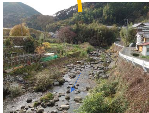
5.4k付近の河道状況 上流部は急流となる。
