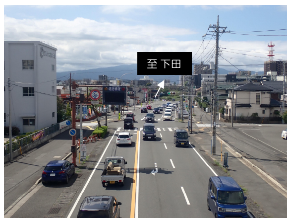
現況写真（南側工区）
