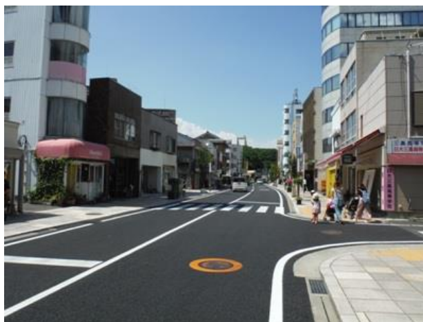
整備後（芝本町工区） 写真
