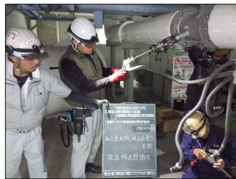
送風機風量計 更新工事 (R7)
