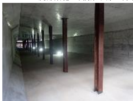
函体内部 (県施工)
