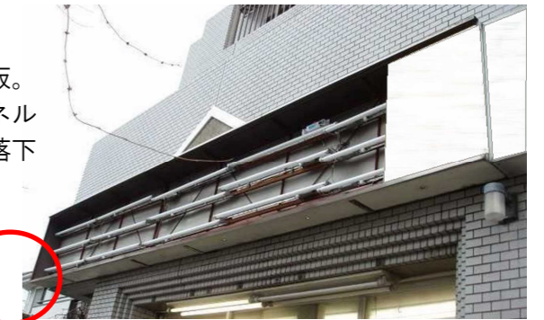
←パネルの変形、ズレ、破損の他、パネルの押さえ枠が変形し落下する場合も。
