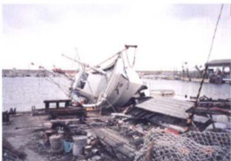
写真-Ⅱ.2.64 船舶の倒壊 (室津港船揚斜路)
