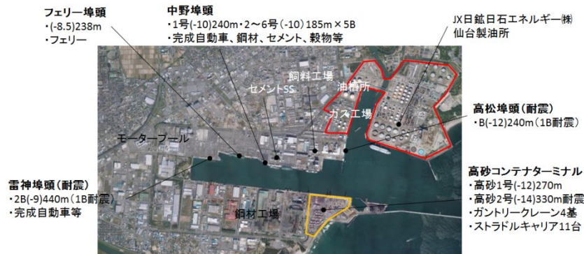
図2 仙台港区の港湾施設
