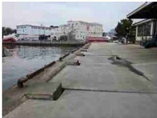
図 23 岸壁の被災状況（エプロン凹凸、地盤沈下）
