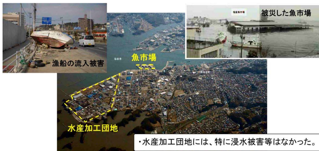
図 21 塩釜漁港被災写真
