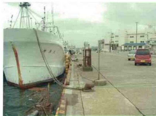
図 23 岸壁の被災状況（エプロン凹凸、地盤沈下）
