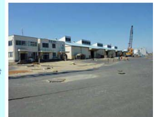
南公共ふ頭の倉庫シャッターや窓が破損
