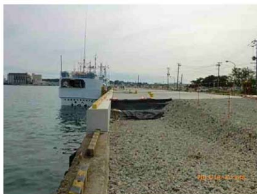
図 29 岸壁の復旧（奥が嵩上げ後）
