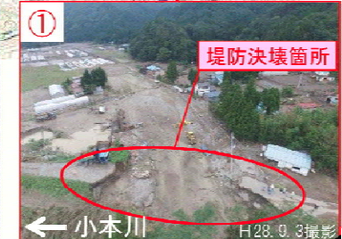
① 堤防決壊状況
