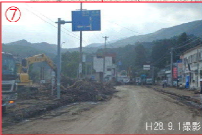
⑦ 道路上に堆積した土砂、塵芥の撤去状況
