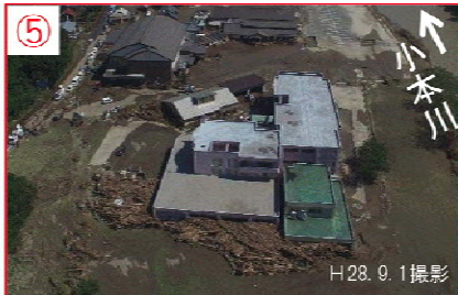
⑤ 流木堆積状況
