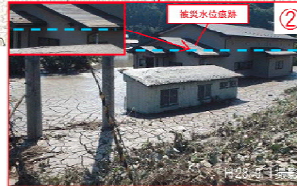
② 浸水解消後の流入土砂堆積状況
