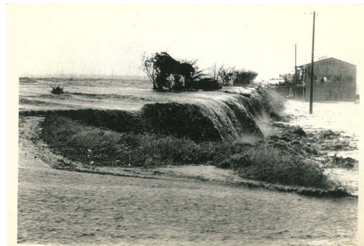
山橋上流右岸 富士市青葉町付近 越水状況
