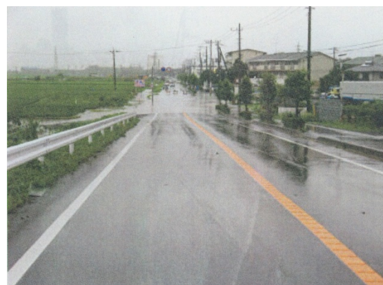
平成19年7月15日江尾江川 市道冠水状況
