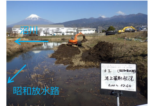
一級河川沼川 河床掘削工事 (富士市中里地先)
