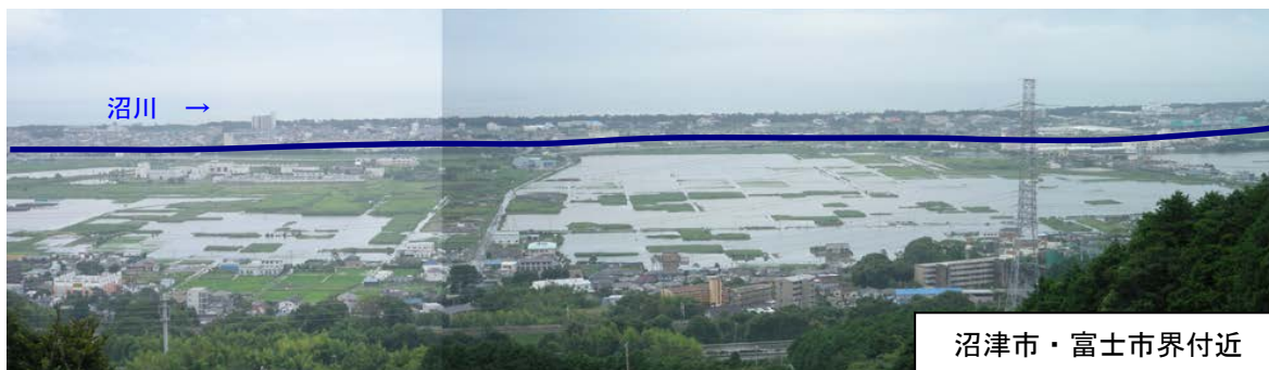
平成19年7月14日洪水による浸水状況
