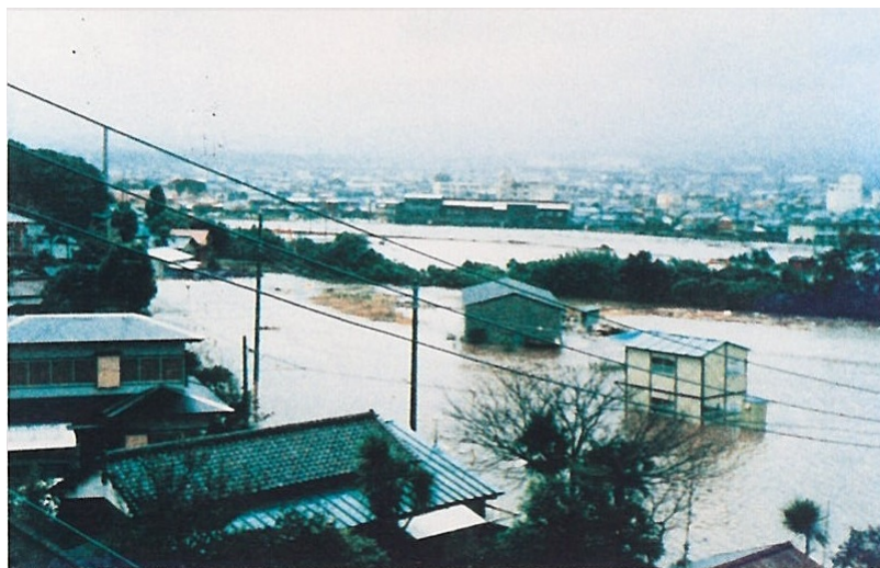
富士宮市大中里付近 浸水状況
