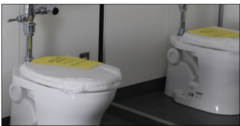
▲工事中のトイレ
