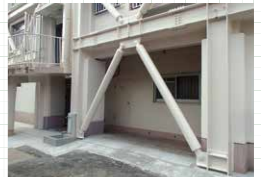
耐震改修工事施工事例
