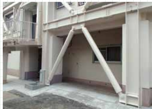
耐震改修工事施工事例
