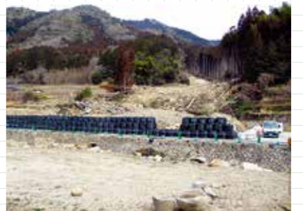
社屋から100m程度上流の山腹崩壊箇所。ここから土砂・流木が下流に流出
