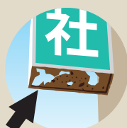
側板底面の腐食、破損
