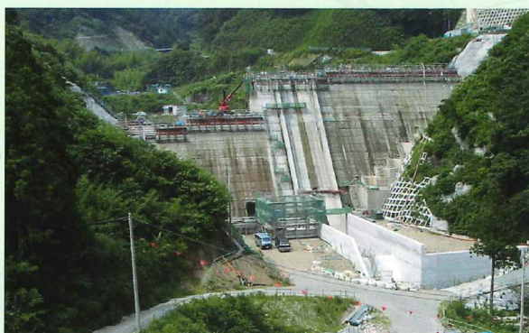
H16.7 本体コンクリート打設中
