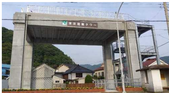
仁科浜地区津波避難タワー
