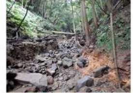
③不安定土砂の状況
