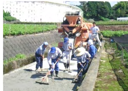
大雨で被害を受けた農道の補修
