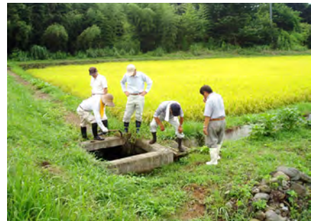
水路の点検状況
