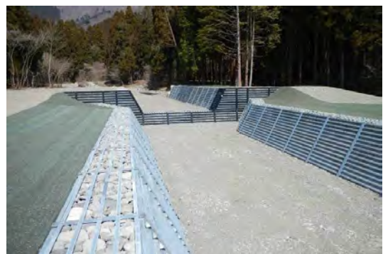
流路を固定し乱流を防止する
