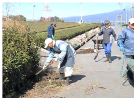
水路の泥上げ
