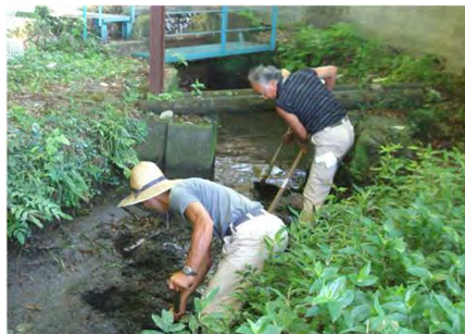
水路の泥上げ作業
