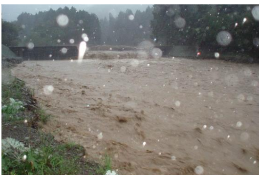
台風後の河川氾状況(富士宮市)
