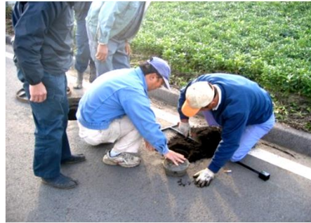
農業用施設の点検
