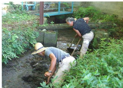
水路の泥上げ作業
