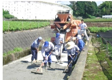
大雨で被害を受けた農道の補修
