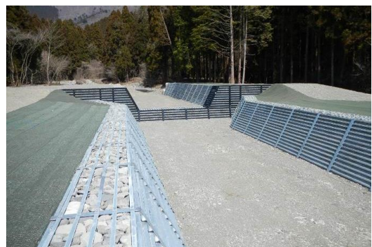
流路を固定し乱流を防止する
