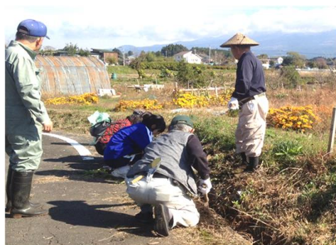
水路の泥上げ
