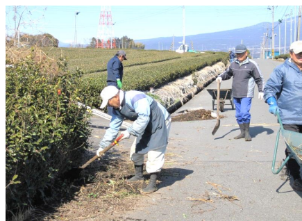
水路の泥上げ
